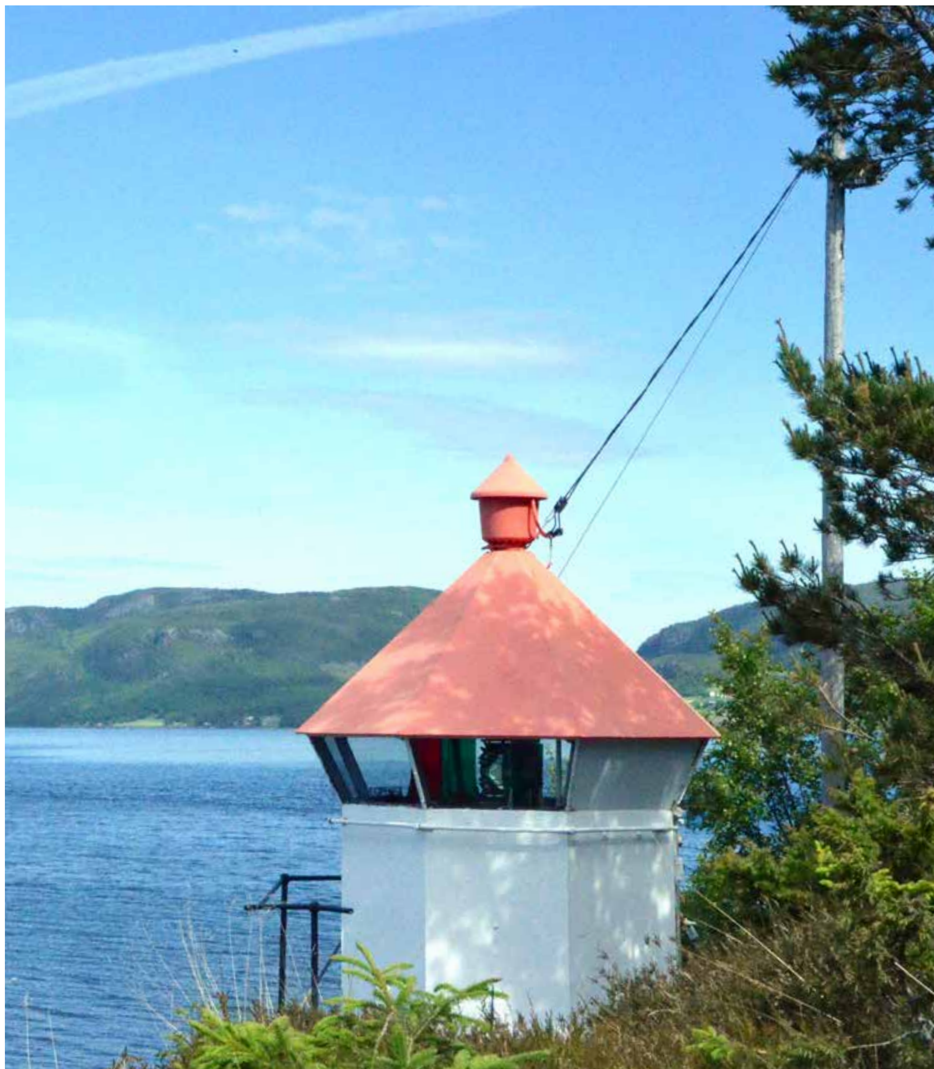
Fyret på Fånes ble satt opp i 1913. Foto Frostingen
